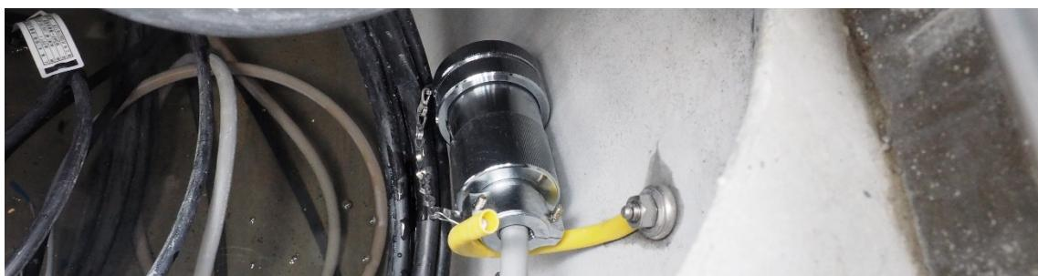
取り出したインカムケーブルをインカムボックスの裏側のコネクタに繋ぐ(下の切り欠けを合わせる)
