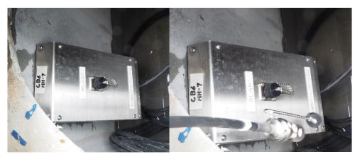
最後に LAN ボックスの LAN 端子と HH の LAN 端子を LAN ケーブルで繋ぎます。
